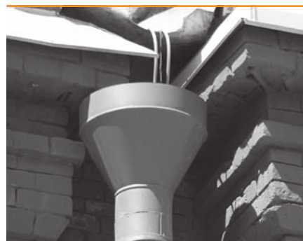
7 водосточные трубы и воронки
