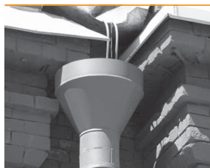
7 водосточные трубы и воронки
